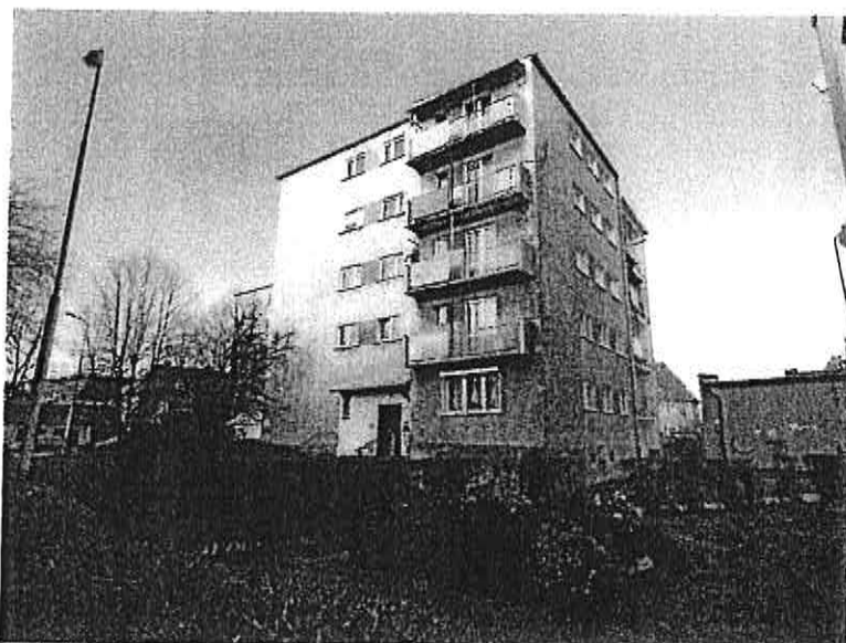
Fot.1. Widok budynku
