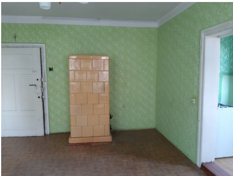
Zdjęcie lokalu do remontu
