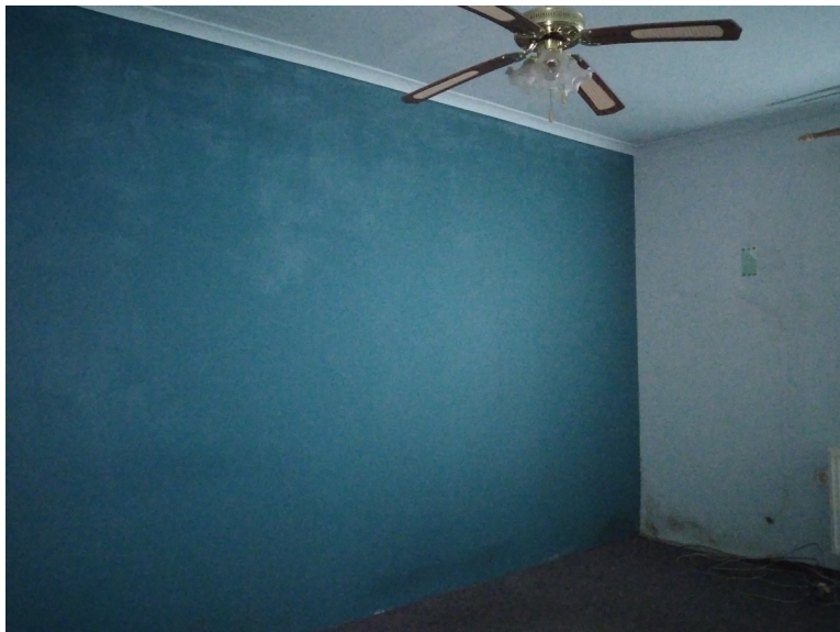
Zdjęcie lokalu do remontu
