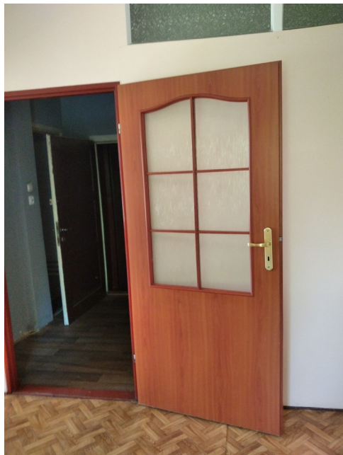
Zdjęcie lokalu do remontu
