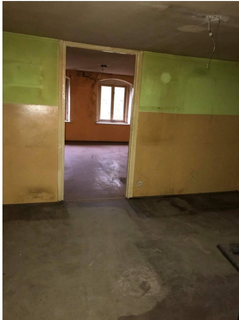
Zdjęcie lokalu do remontu
