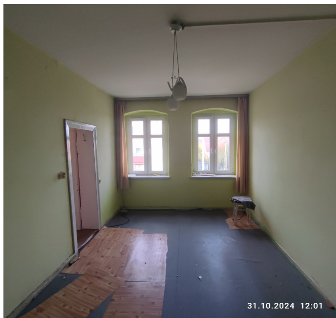
Zdjęcie lokalu do remontu
