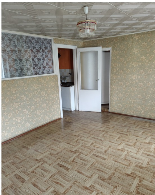
Zdjęcie lokalu do remontu
